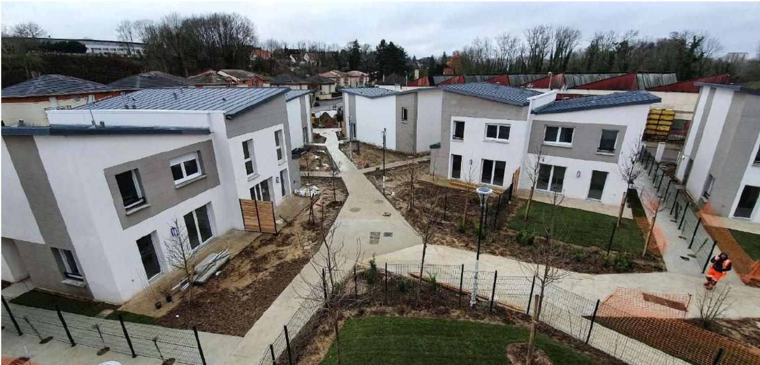
Collectif Accession: 19 logements, structure béton sur pieux, R+3 sur 1 niveau de sous-sol (commun), toiture terrasse végétalisée.
